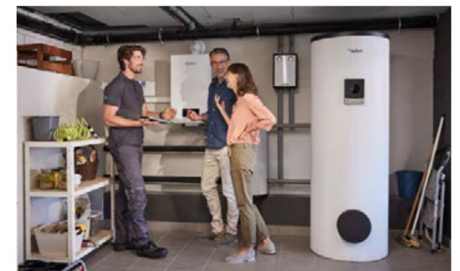
Hybridsystem aus Gas-Brennwertgerät, Puffer- und Warmwasserspeicher sowie außen aufgestellter Wärmepumpe
