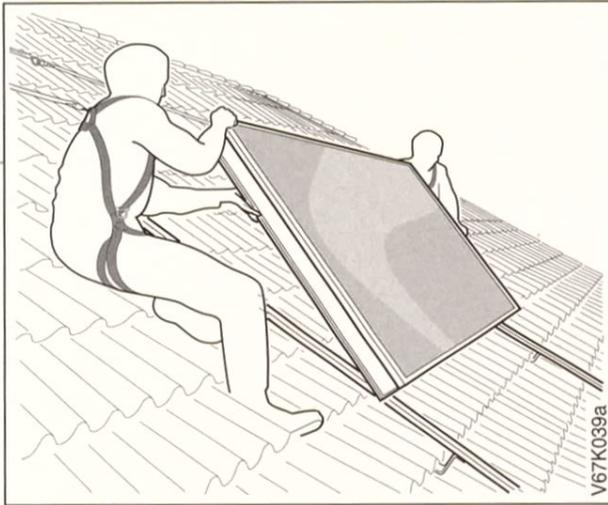
Bild 3.11 Kollektor an den unteren beiden Hammerkopfschrauben der Montage­schienen absetzen.
