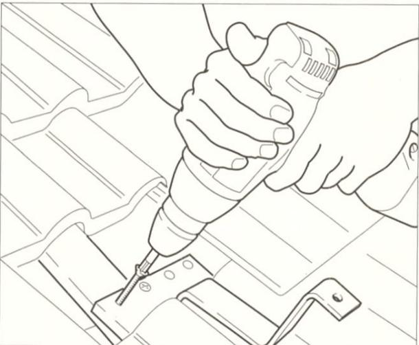
Bild 3.9 Sparrenanker mit Spax-Schrauben (6x80) befestigen. Wenn die Dachlatten stärker als 30 mm sind, dann die Sparrenanker entsprechend unterfüttern.
