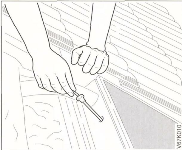
Bild 4.11 Solarfühler in Fühlerhülse stecken. Gummistopfen auf Kabel schieben und damit Öffnung verschließen. Kabel ins Dach führen und an den Regler anschließen.
