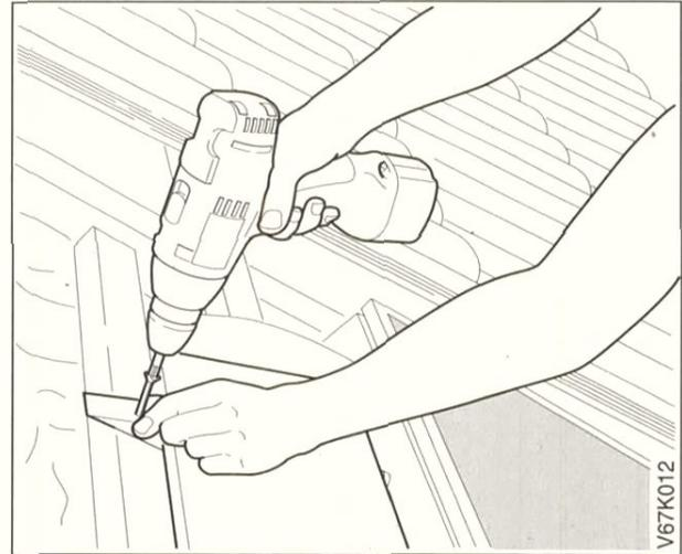
Bild 4.12 Holzauflage an Kollektor anlegen und mit Schnellbauschrauben befestigen.
