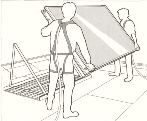
Bild 3.7 Zwischen die herausragenden Schrauben den Kollektor so einsetzen, dass er mit oberer und unterer Mutter abschließt.
