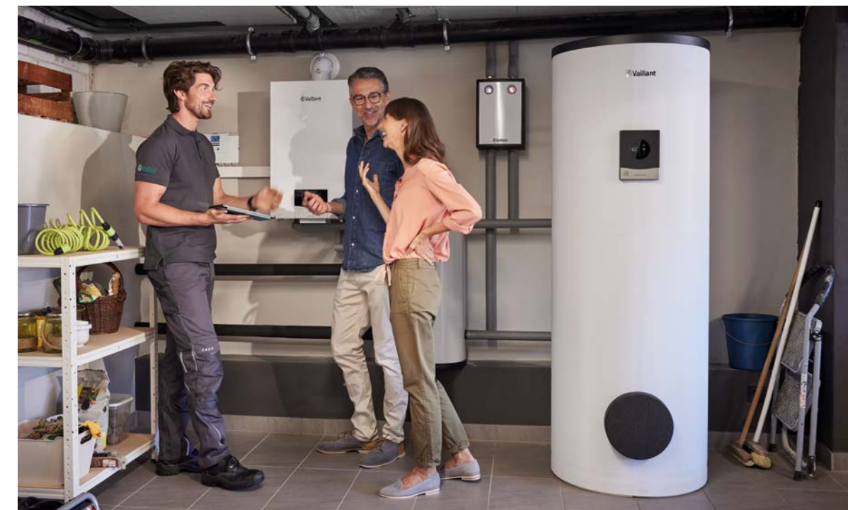
Hybridsystem aus Luft/Wasser-Wärmepumpe sowie Gas-Brennwertgerät und Puffer- und Warmwasserspeicher
